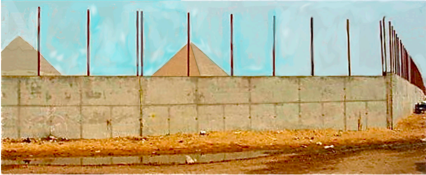
Hohe Gizeh-Mauer mit noch fehlendem Sichtzaun und fehlender technischer Ausstattung.
